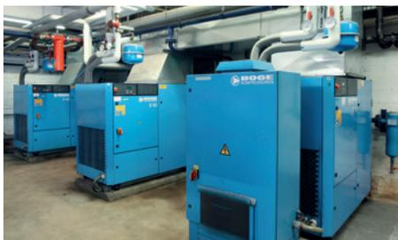
**Deux compresseurs à vis lubrifiée de la Série S 60, et un compresseur à variateur de fréquence de la Série SF 61, produisent de l'air comprimé en fonction des besoins réels.**
